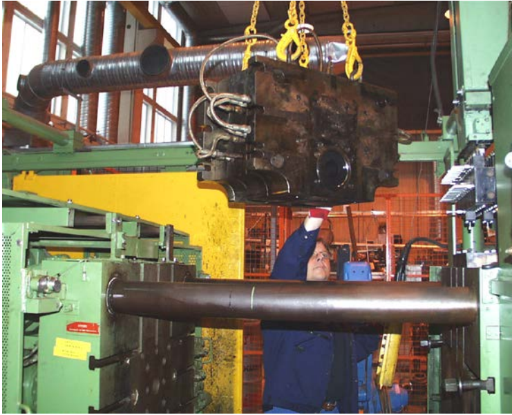
Kuva 9. Muottia nostetaan paikoilleen. On olemassa laitteita, joilla muotti voidaan siirtää koneen sivulta paikoilleen, mutta nosturin käyttö on kuitenkin hyvin yleistä.
