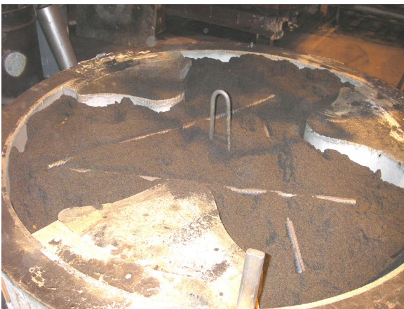
Kuva 52. Keernaan asennettu tukiraudat ja nostolenkki keernan täyttövaiheessa
