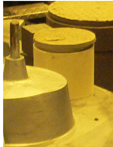
Kuva 197. Kanavistojen ja holkkien aukot peitetty kansilla kaavauksessa. Seuraava tiiliputki tai holkki lisätään kaavauksen eli muotin täytön edistyessä
