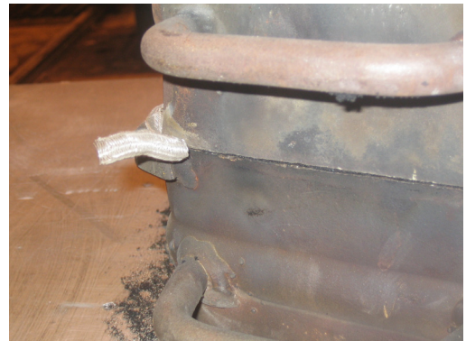
Kuva 167. Kaasunpoistolanka kehästä ulkona
