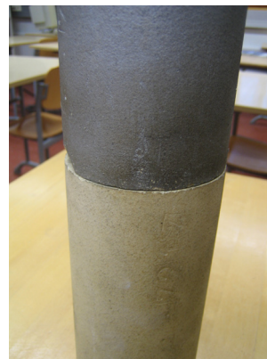
Kuva 192. Kanavaputket yhdistetty
