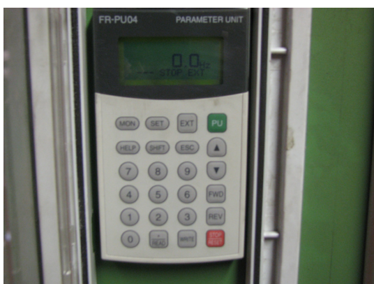
Kuva 216. Hartsi- ja kovetepumpun ohjaustaulun säätöyksikkö
