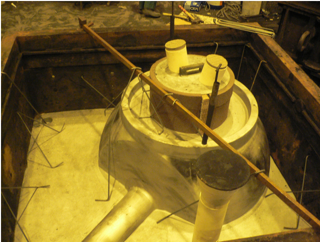
Kuva 183. Hiekkakoukkuja aseteltu kehään valmiiksi ennen kaavausta
