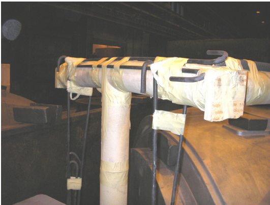
Kuva 196. Esivalmisteltu kanavistopaketti tuettu kaavausta varten
