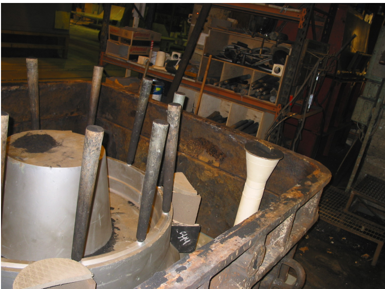
Kuvat 160. Kehävarusteita ja kanavistorakenne asetettu mallin päälle kehänsisään
