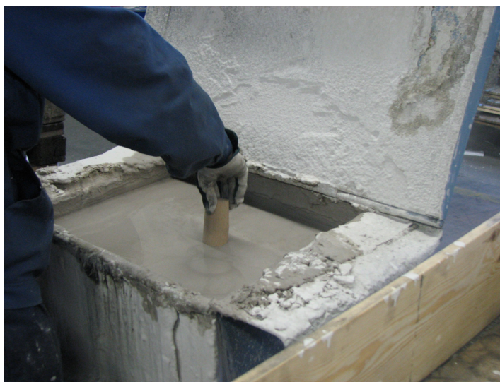
Kuva 278. Kastopeitostusta keernakanta ylöspäin
