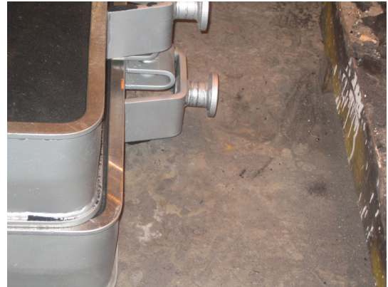
Kuva 351. Kehän sulkeminen ja nosto vaikeaa kehien olleessa ristissä
