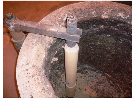
Kuva 423. Teräsvalun senkan stopparilaitteisto
