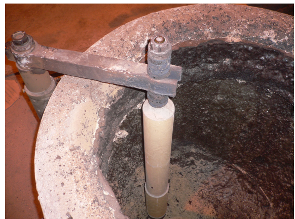
Kuva 392. Senkan valmistelua, stoppari asennettu senkkaan
